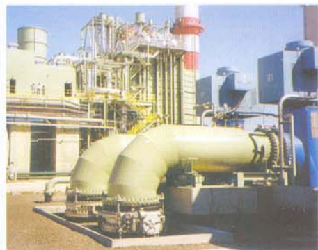
JUNTAS DE EXPANSÃO DE BORRACHA. Os corpos são fabricados em diversos elastômeros: Cloroprene, nitrílica, EPDM, EPDM sanitário, natural, hypalon, butilica e revestidas em PTFE. São fornecidas desde 1" até 80" de diâmetro.
